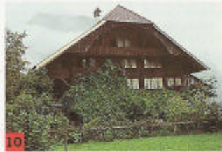
10 Wiler Ründihaus von 1792, erbaut für Jakob Reber , Zimmermeister nicht genannt. Südorientiertes Wohnhaus in Ständer-/Blockbau. Siehe Bild.
